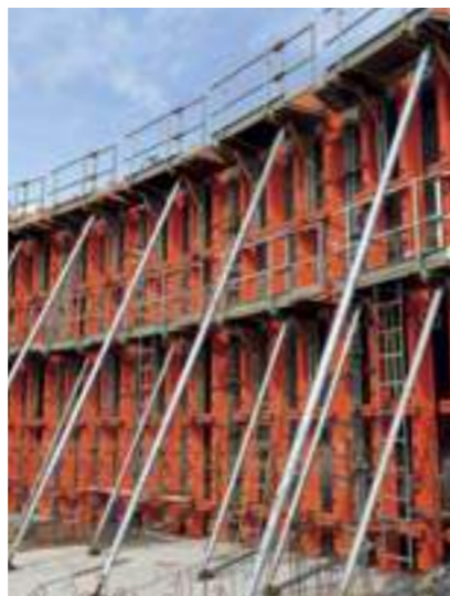
Trapezträger-Rundschalung mit Klammerverbindung
