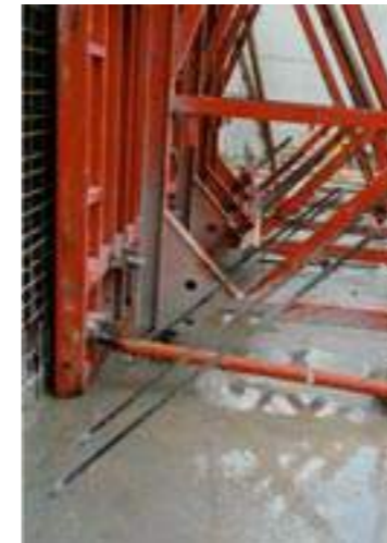
Stützböcke PERI Rückverankerung in korrekter 45°-Lage
