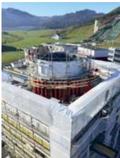
Trapezträger-Rundschalung mit Holzschalhaut
