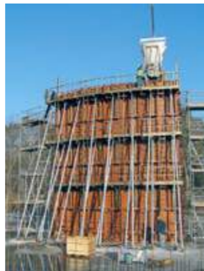
Trapezträger-Rundschalung mit Stahlschalhaut
